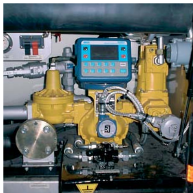
Применение на автоцистернах СУГ с температурным зондом PT100
